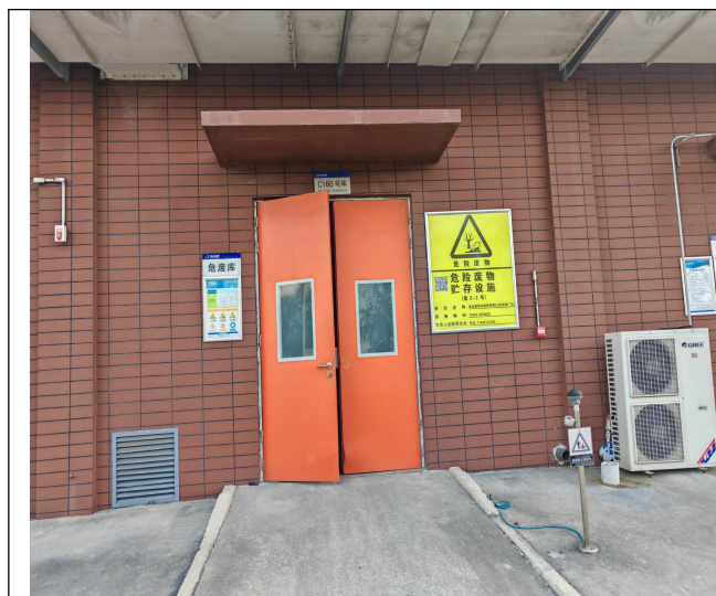
危废库（废固库）
