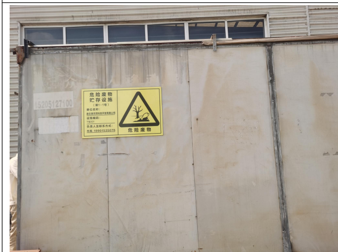
危废仓库及标识牌
